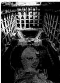
Blick in den Innenraum: Baubeginn der Konferenzhalle
